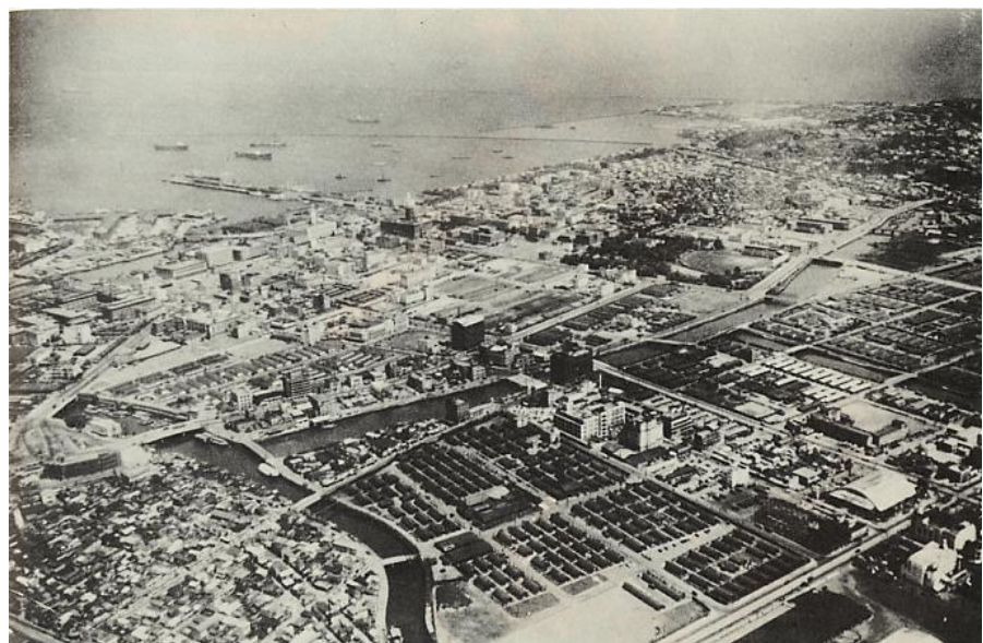
右：昭和20年代前半の関内・関外地区、左側を流れる川は大岡川、手前には米軍のカマボコ兵舎が並ぶ (写真：横浜市提供)
